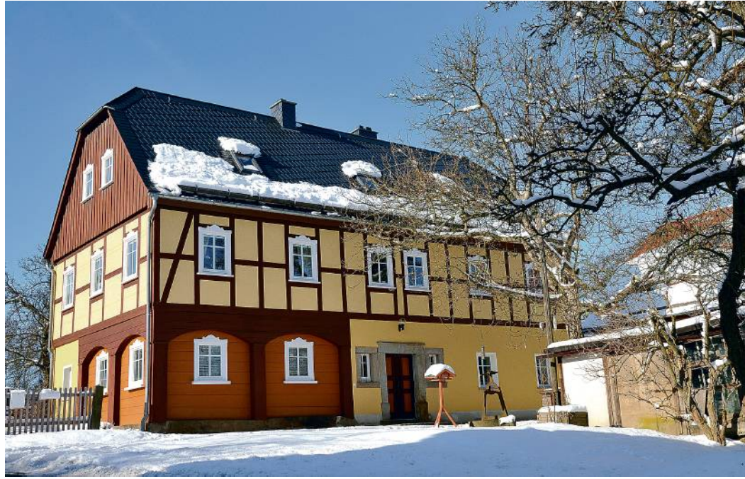
Taustellen auf dem Dach sind ein Zeichen für Wärmeverluste durch die Dachdämmung. Dann sollte der Zustand der Dämmung von einem Profi untersucht und gegebenenfalls saniert werden.
